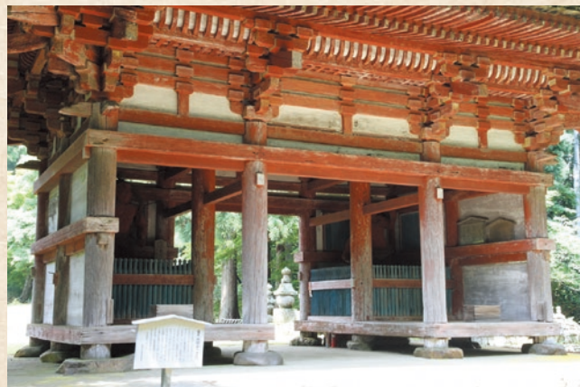
今回修理前の二王門 下層の状況
