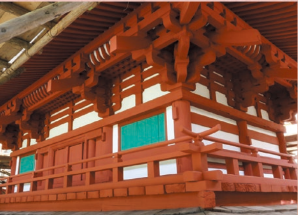
塗装完了(上層)
