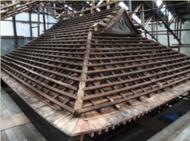
屋根板の取り外し完了
